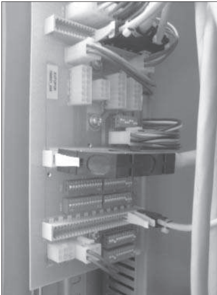
Csatlakozás az Elektrához
